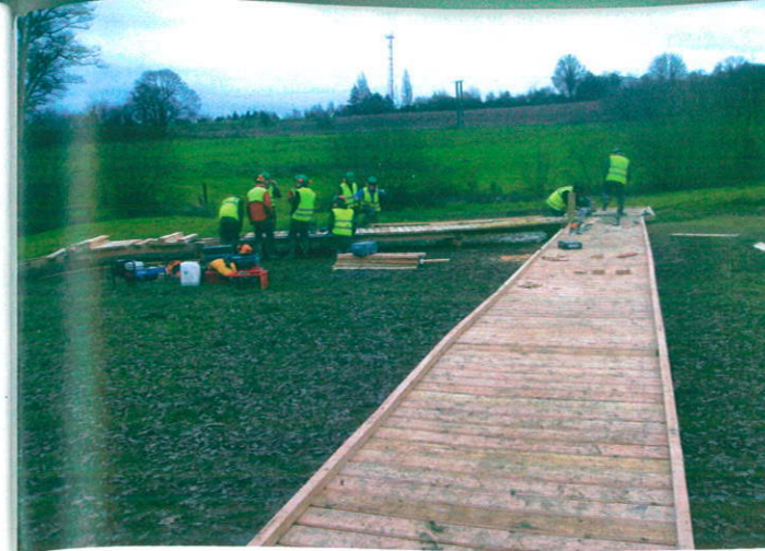
Fabrication de la passerelle
