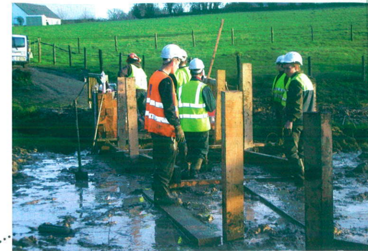
Installation de la passerelle
