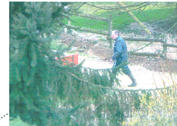
Jean, installation des barrières
